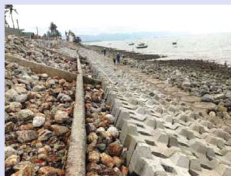
Đê biển Cát Hải được kiên cố hóa bằng tấm đan Hohl-quader
